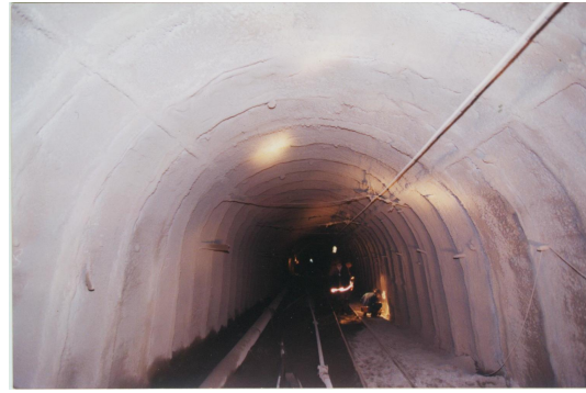
图 16 网壳锚喷工程应用
