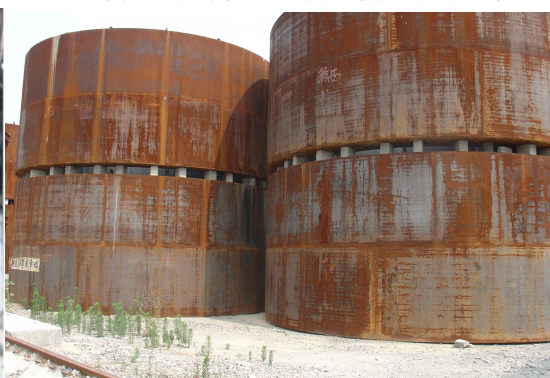
图 9 双层钢板高强混凝土复合井壁现场应用
