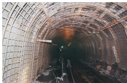
图 14 网壳锚喷工程应用
