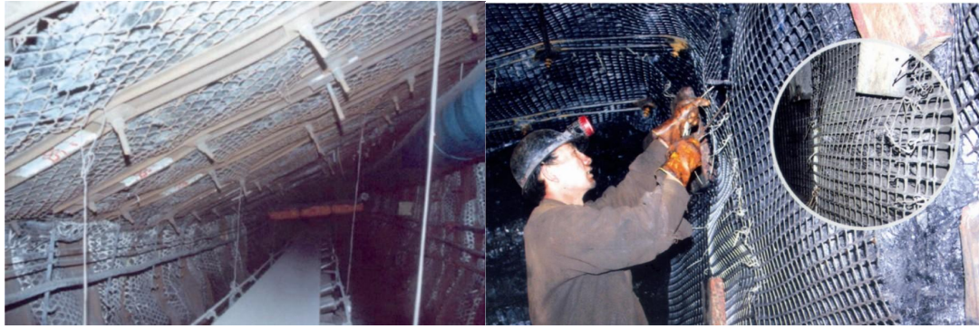
图 10 玻璃钢锚杆及复合材料网锚喷支护系统井下应用图片
