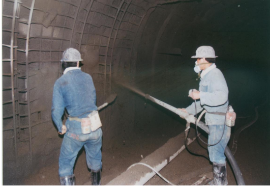
图 15 网壳锚喷工程应用
